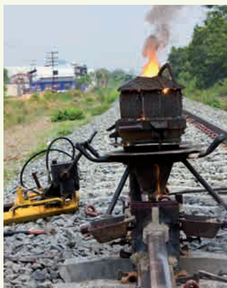
2. A vasúti sínek hegesztése termitreakcióval szintén redoxireakció
