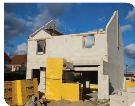
■ Ytong falazóelemekből épülő ház
