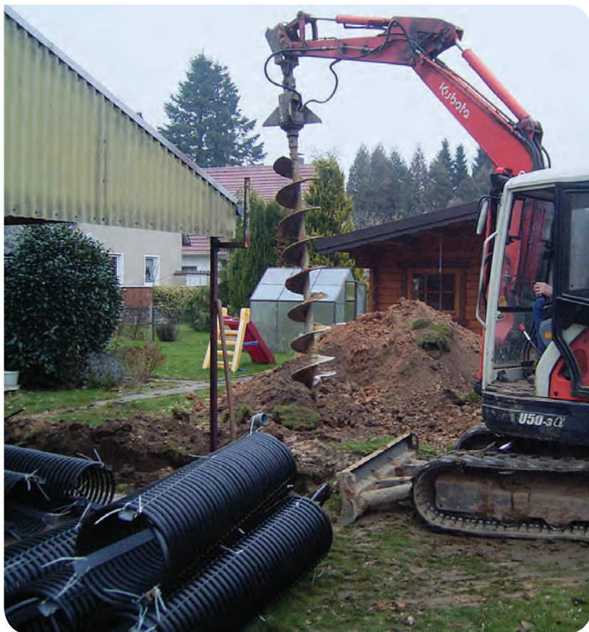
■ A kb. 2 méter magas és fél méter átmérőjű spirálcsövek kétméterenként függőlegesen lesznek a földbe helyezve
