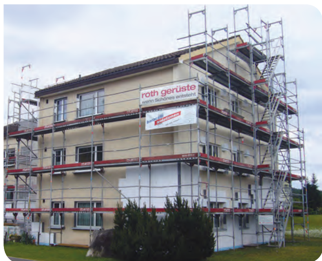
■ Polisztirol habból készült szigetelő lemezek felragasztása a fal külső felületére
